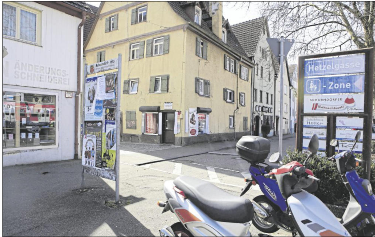
Der Sanierungsbedarf in der Weststadt und speziell entlang der Rosenstraße ist nach wie vor groß. Beim Gebäude Rosenstraße 17 (Bildmitte) immerhin ist Abhilfe in Sicht, nachdem so gut wie sicher ist, dass sich die Stadtbau des denkmalgeschützten Objekts annimmt. Bilder: Palmizi
